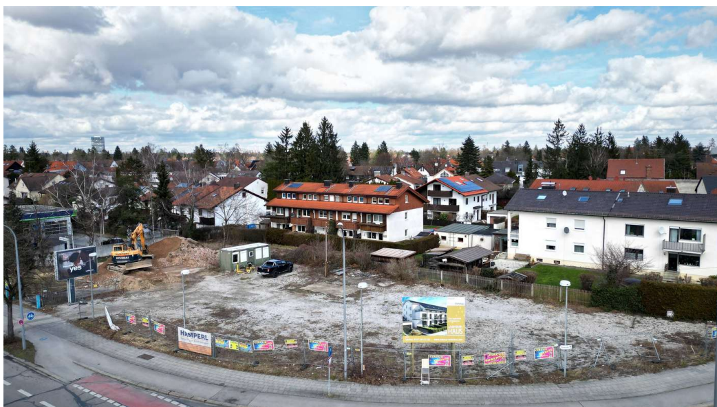
Umstrittenes Bauvorhaben: An der Heinrich-Wieland-Straße in Trudering soll ein Flexiheim entstehen. © Marcus Schlaf
